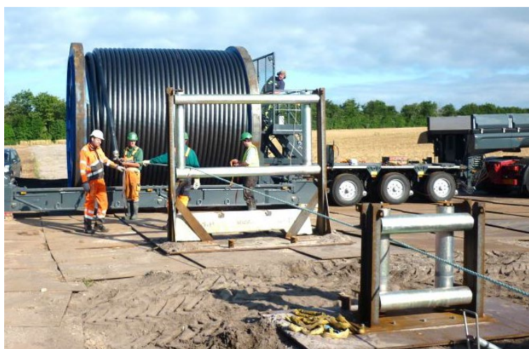
Figur 2-15 Kabeltromle på blokvogn
