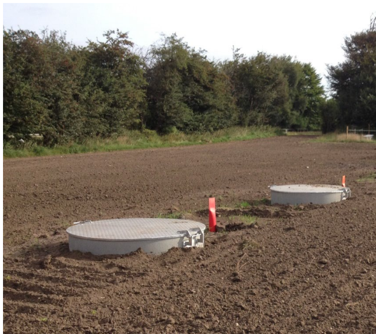
Figur 2-2 Eksempelfoto af linkbokse i terræn
