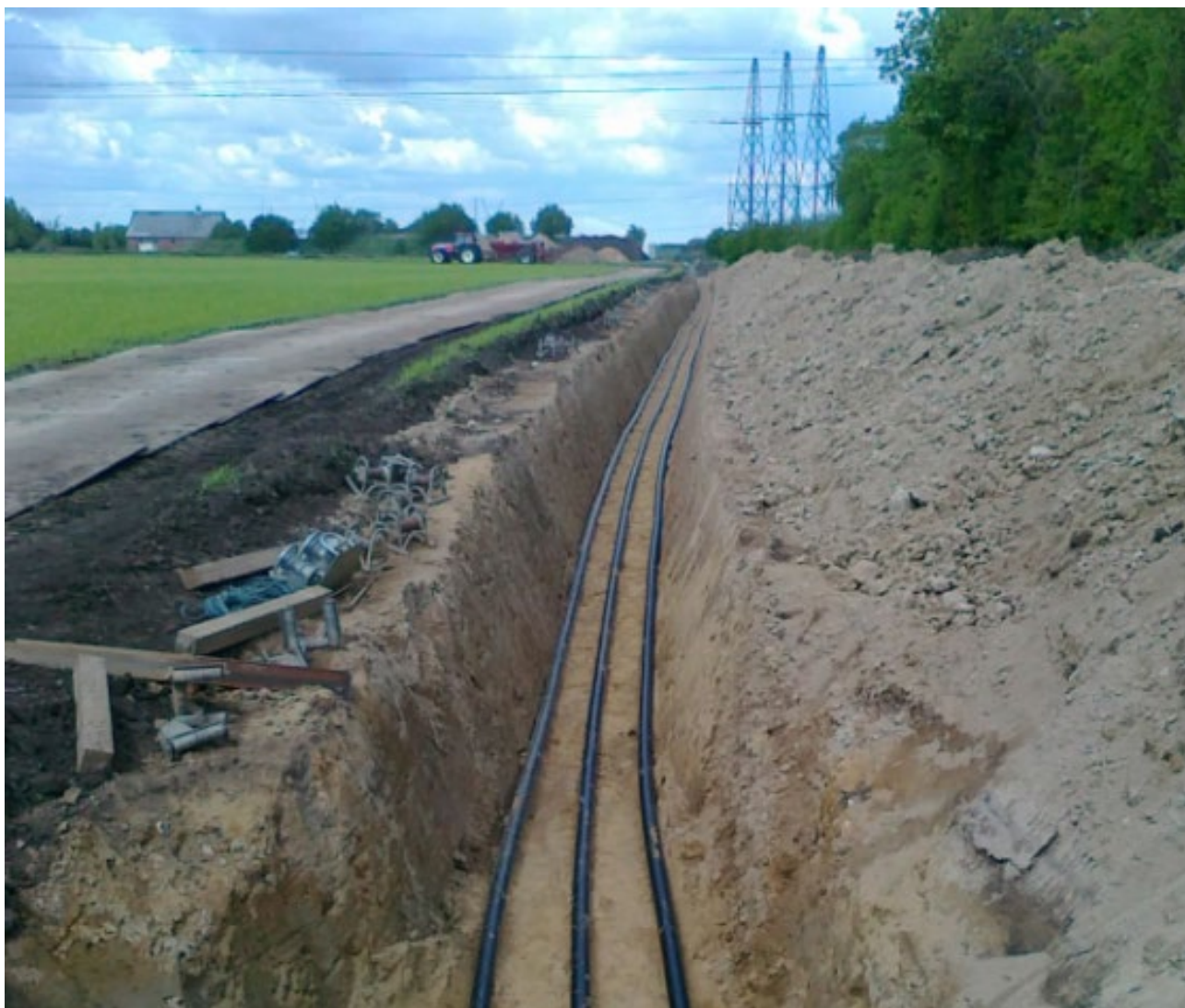
Figur 2-6 Kabelanlæg lagt ud i åben grav
