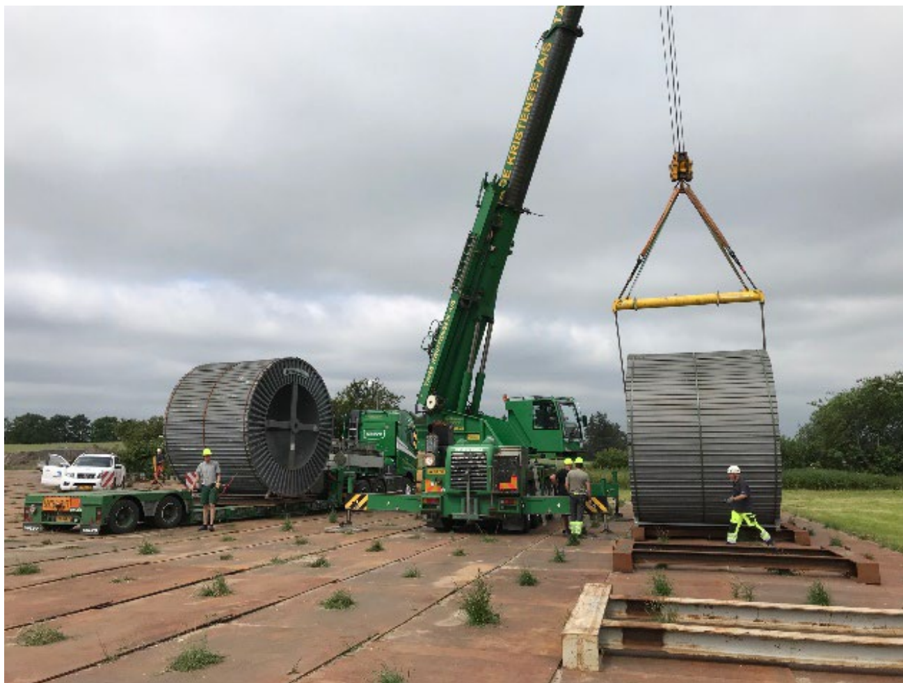
Figur 2-9 Håndtering af kabeltromler på tromleplads
