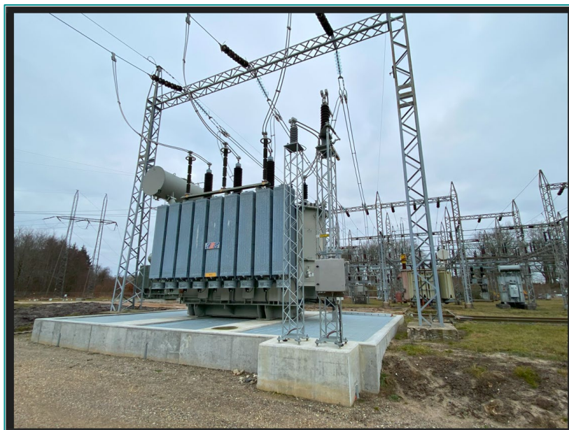
Figur 5-2 Kompenseringspole på støbt opsamlingsbeholder
