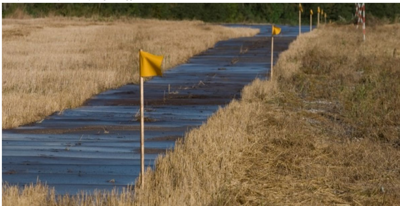
Figur 2-11 adgangsvej med køreplader
