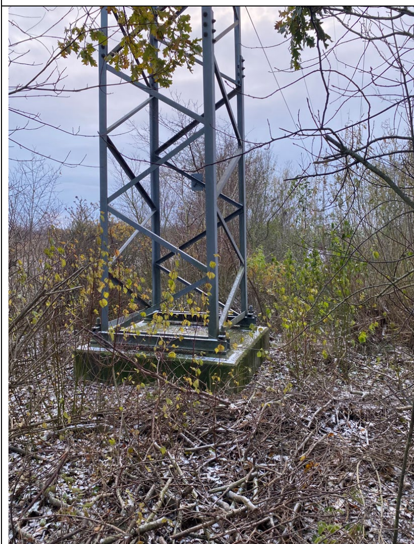
Figur 8. Udsyn fra mast mod syd. Foto fra besigtigelse d. 29. november 2023.
