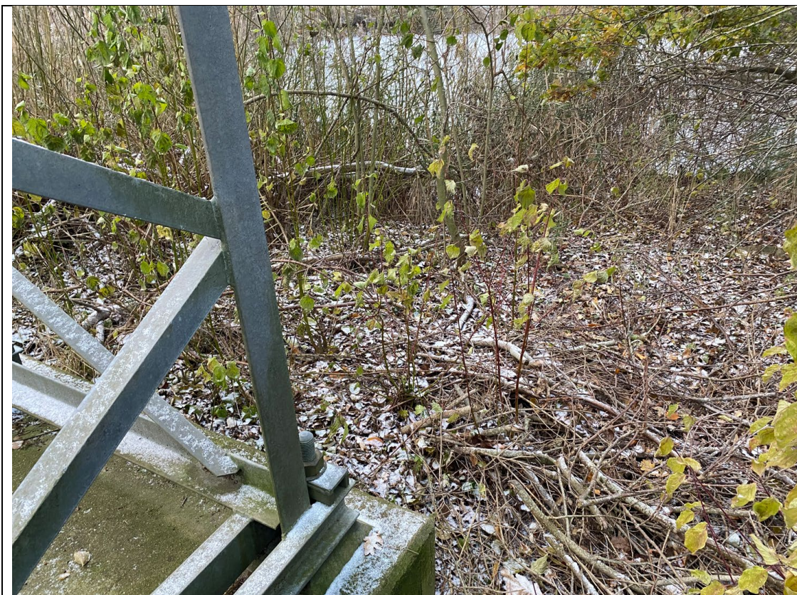
Figur 9. Udsyn fra mast mod vest ud mod søen. Man kan ane kanten af pladefundamentet ned mod søen ca. 2 m fra masten. Her ligger pladefundamentet højt i terræn, hvilket gør fjernelse af mastefundamentet mindre indgribende. Foto fra besigtigelse d. 29. november 2023.
