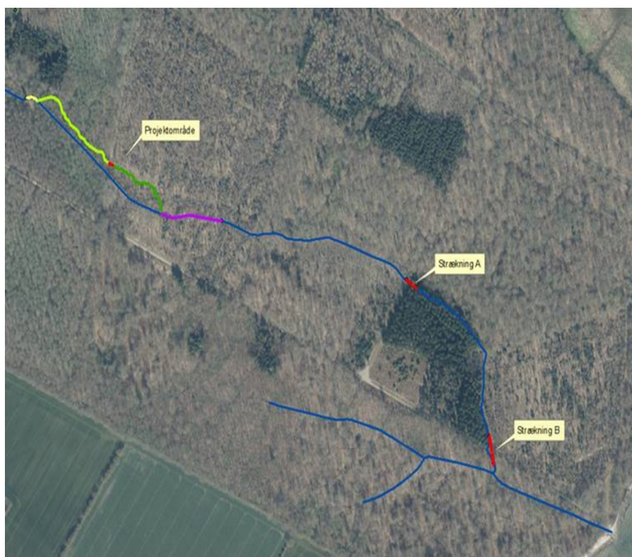
Figur 3-7 De to rørlagte strækninger længere nedstrøms i Østergård Bæk. Strækning A og strækning B (rød markering).
