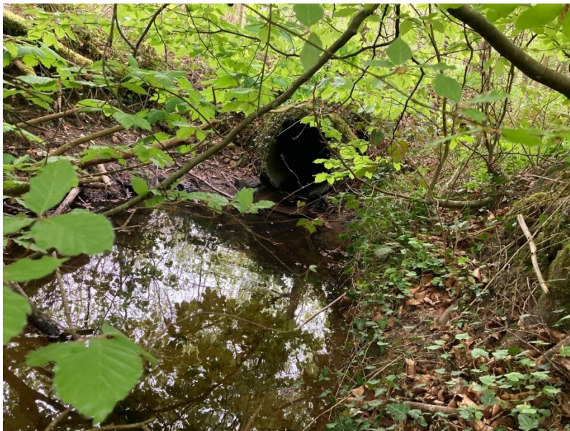
Figur 3-9 Rørbro ved Grønnevej.
