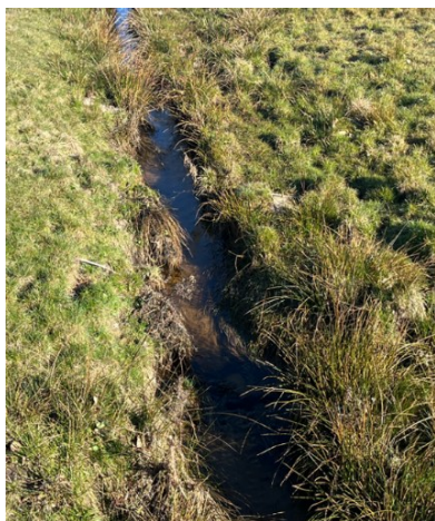
Figur 13 Farre Bæk ved krydsningsstedet, hvor vandløbet underbores af ub8.
