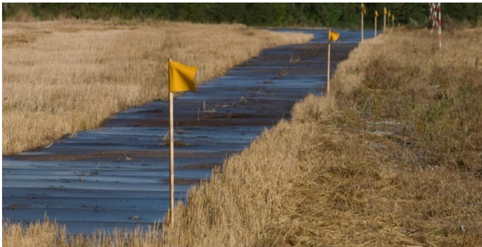
Figur 2-10 adgangsvej med køreplader
