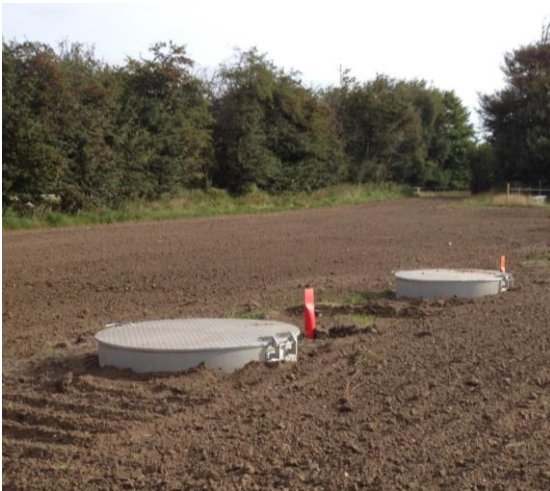
Figur 2-2 Eksempelfoto af linkbokse i terræn.
