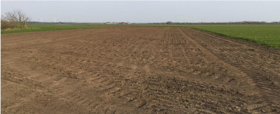
Figur 2-5 Eksempelfoto på udjævnet anlægsbælte
