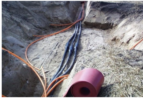
Figur 2-12 Kablerne er muffet sammen
