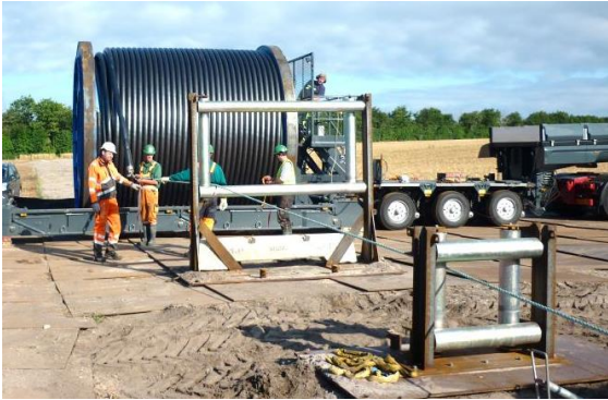
Figur 2-14 Kabeltromle på blokvogn
