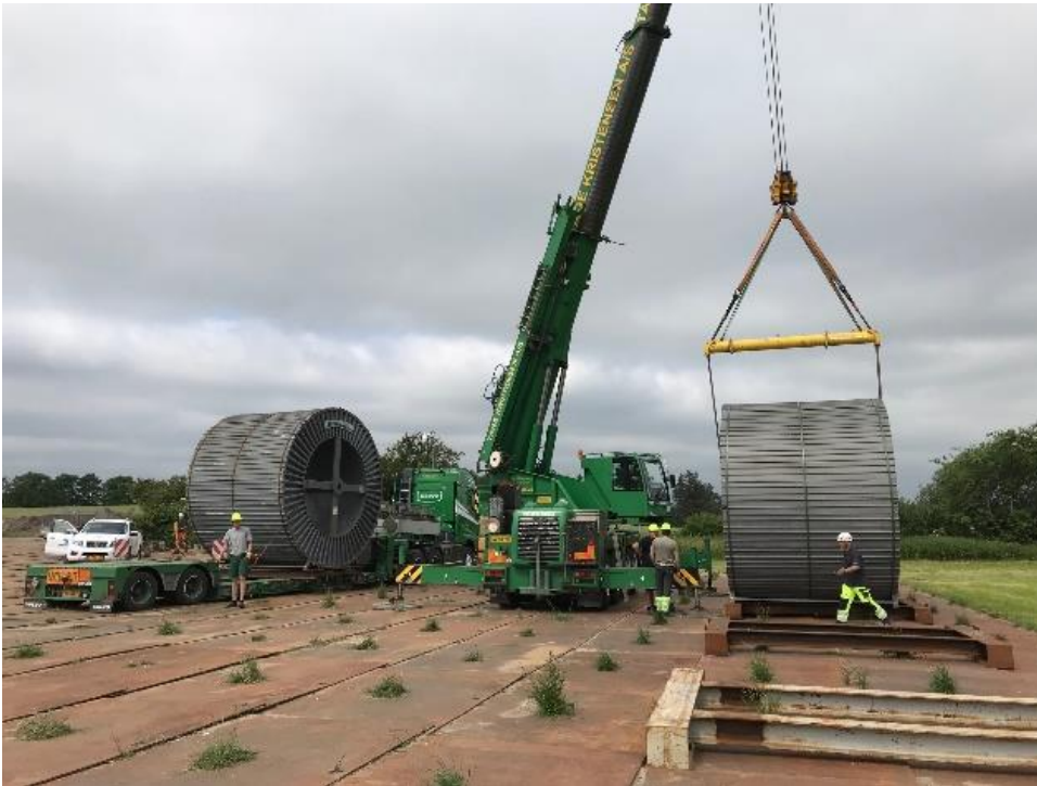
Figur 2-8 Håndtering af kabeltromler på tromleplads
