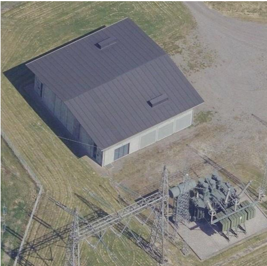
Figur 4-3. Eksempel på en bygning indeholdende et 275 kV-gasisoleret kompakt indendørs koblingsanlæg (GIS).
