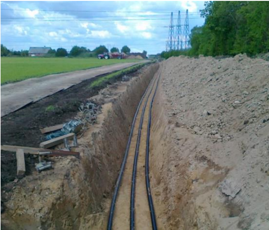
Figur 2-6 Kabelanlæg lagt ud i åben grav
