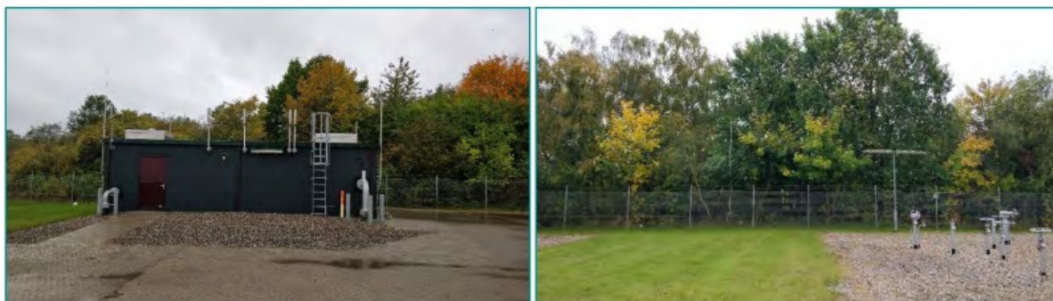
Figur 3. Eksempel på en M/R-station til venstre og en linjeventil-station (L/V-station) til højre.
