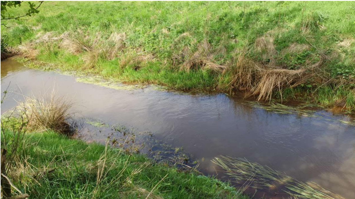
Figur 4-56 Dambæk ved underboringenslokationen. Billedet er taget på feltbesigtigelse i april 2024.
