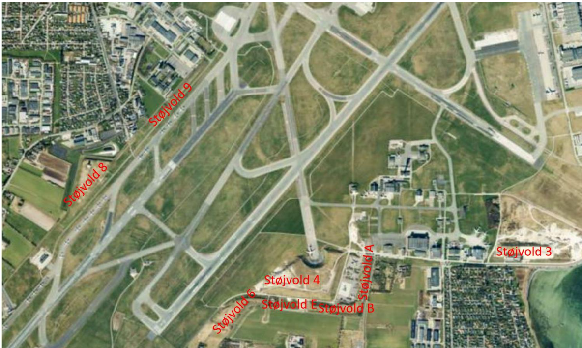
Figur 5: Støjvolde på Københavns Lufthavns område. Det er kun støjvold 3, 4 og 6, der i dag er aktive for modtagelse af jord. (4)
