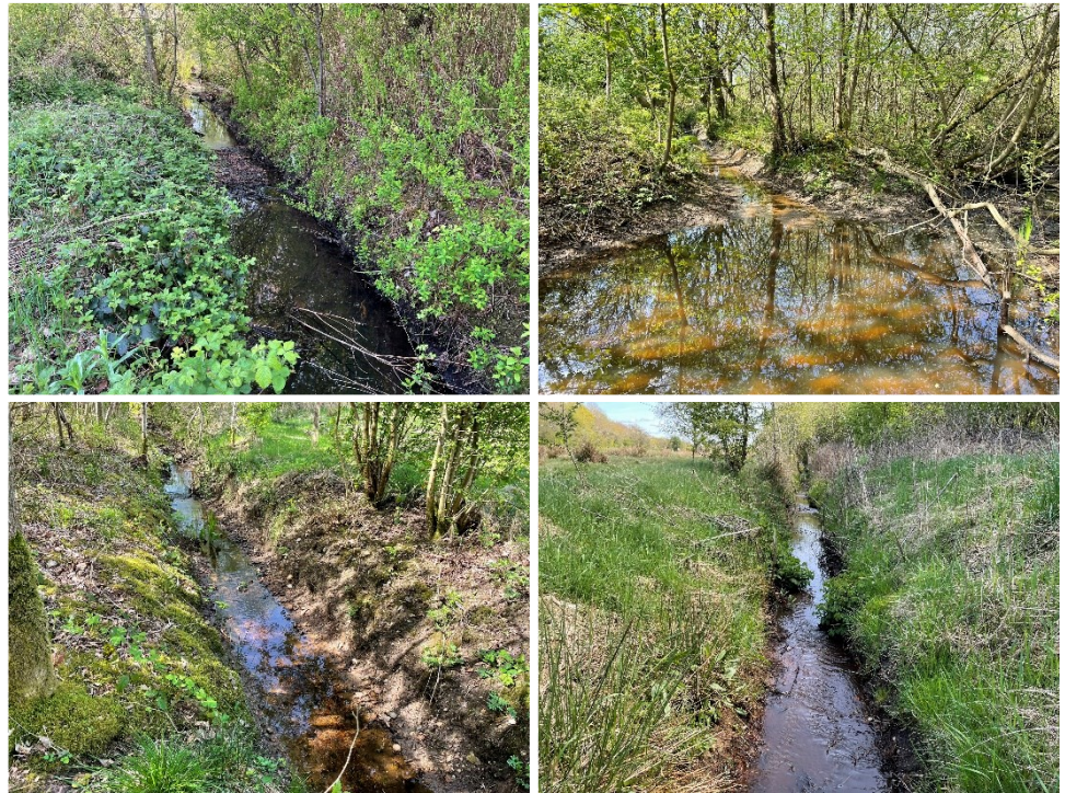
Figur 5-11 LK05V opstrøms krydsningspunktet (øverst) set i retning mod vest og nedstrøms krydsningspunkt (nederst) set i retning mod øst. Opstrøms er vandløbet overskygget fra krat og skov og har en passage hvor brinkerne er gravet ud således at der permanent står mere stillestående vand (Ø.th.). Nedstrøms er vandløbet delvist overskygget af kratkov (N.tv.) og løber længere nede ud langs med græsmarker (N.th.).
