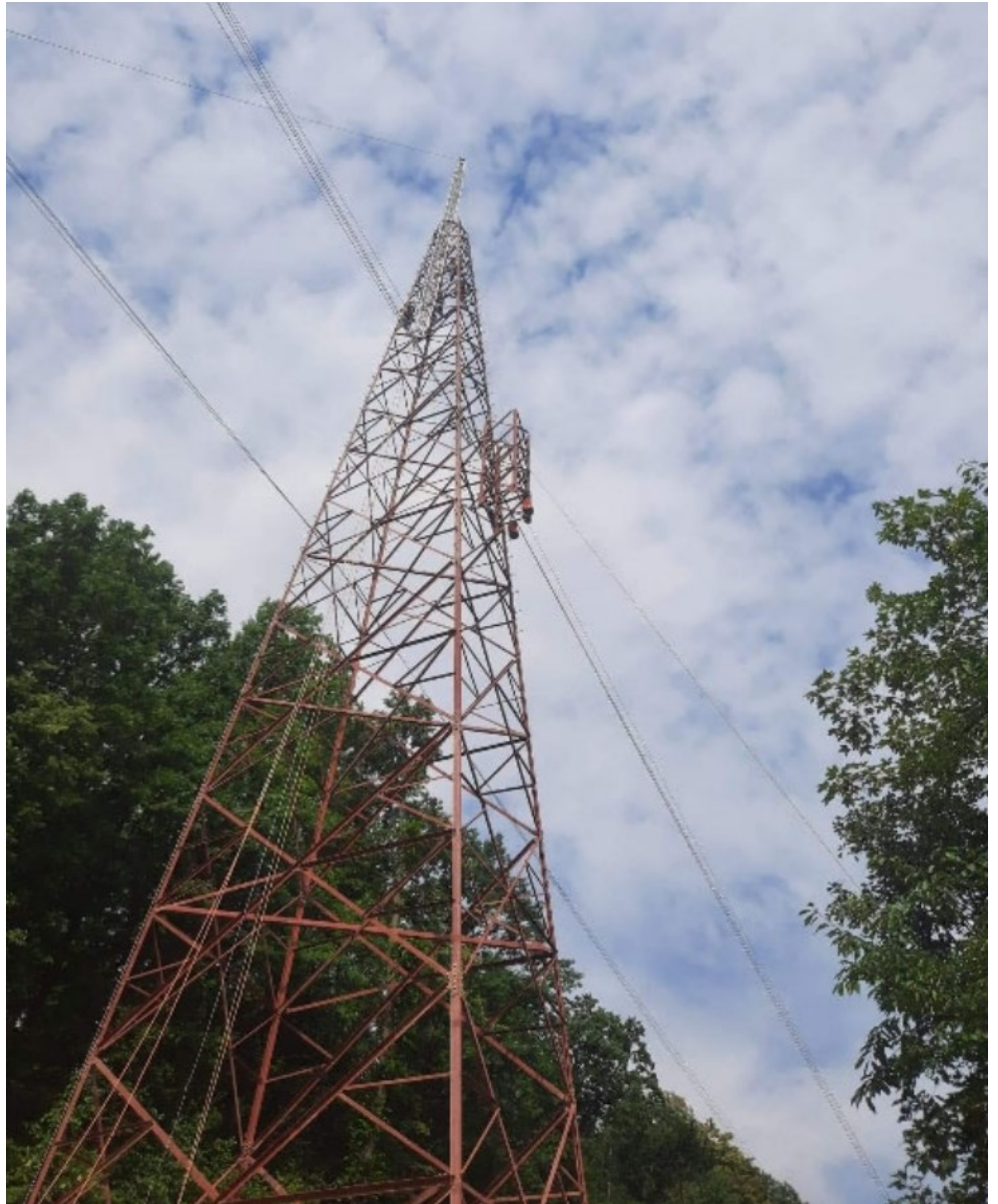
Figur 2-2 Derrick i brug ved demontering af mast.
