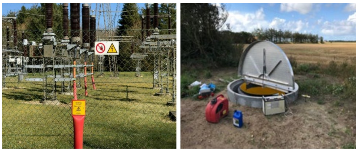
Figur 3.12 Eksempel på markeringspæl og linkboksbrønd.
