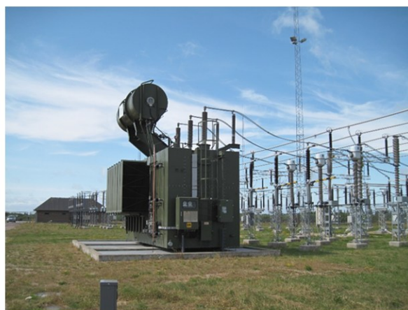
Figur 3.3 Luftledningsfelt med overgang til kabler (til venstre) og kompenseringsspole, samt el-tekniske komponenter i højspændingsfelter (til højre).
