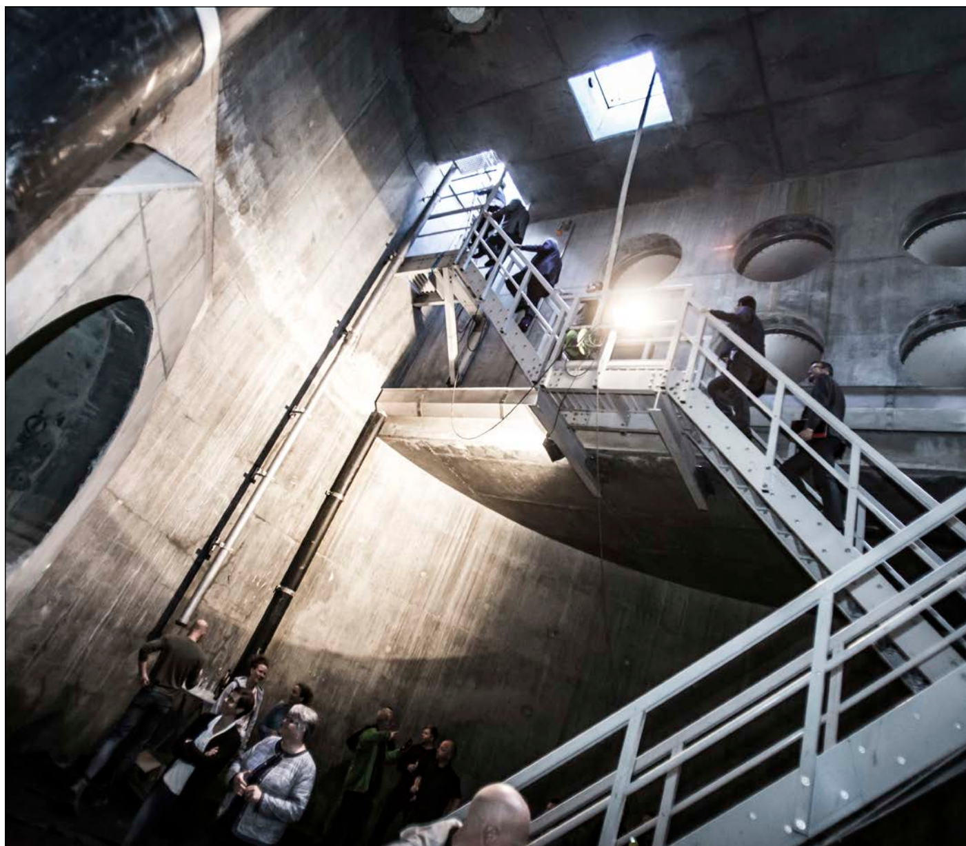
Udløbsbygværket ved en mindre skybrudstunnel, Østerbrotunnelen, ved Lautrupkaj blev indviet i 2017. Til venstre i billedet er tunnelrøret og øverst til højre kan man se de rør, hvor vandet vil blive lukket ud i havnen ved et skybrud.
