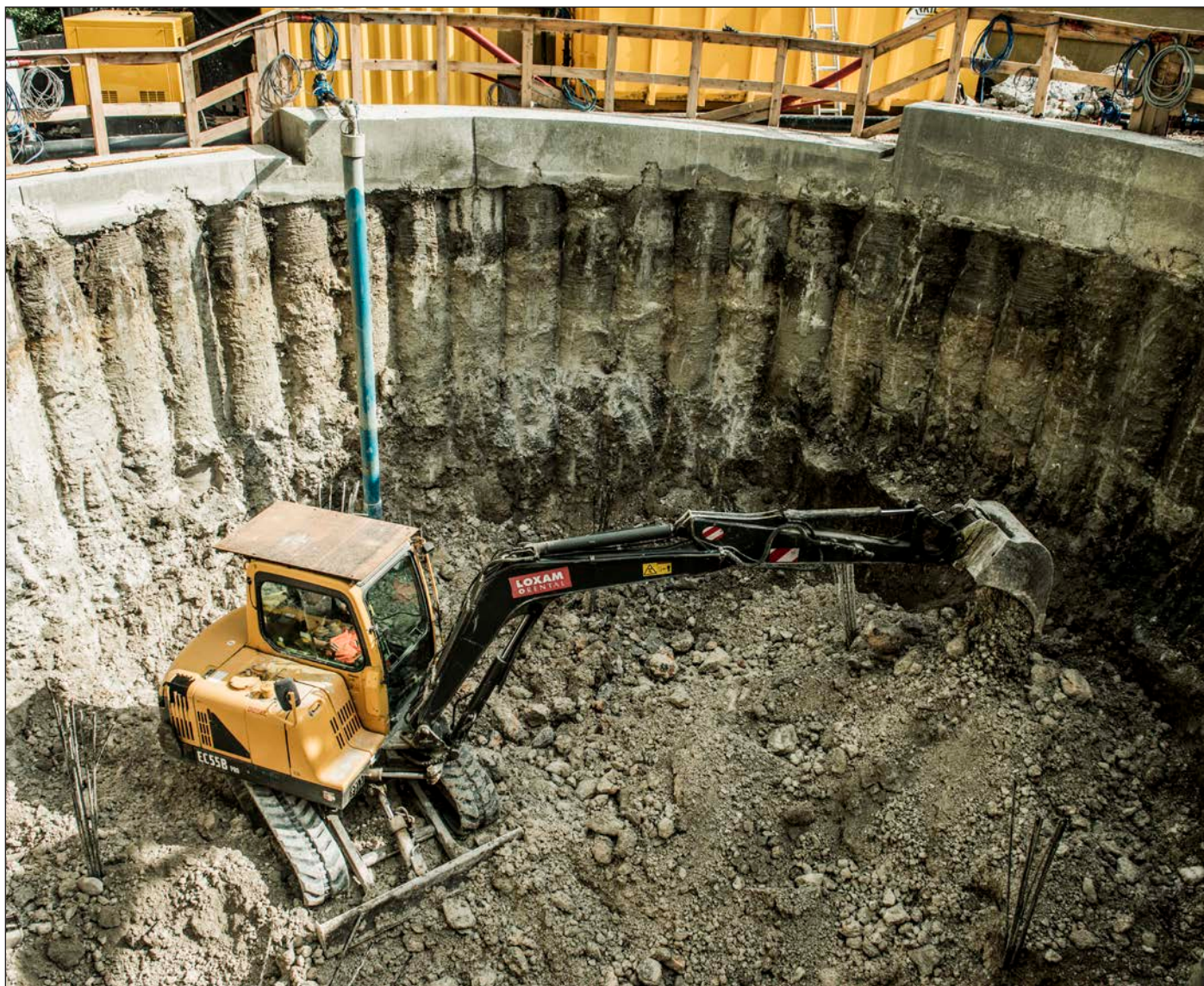
Skakt udført med sekantpæle.
