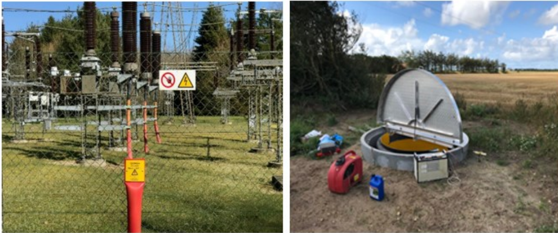
Figur 7 Eksempel på markeringsstander og linkboksbrønd.
